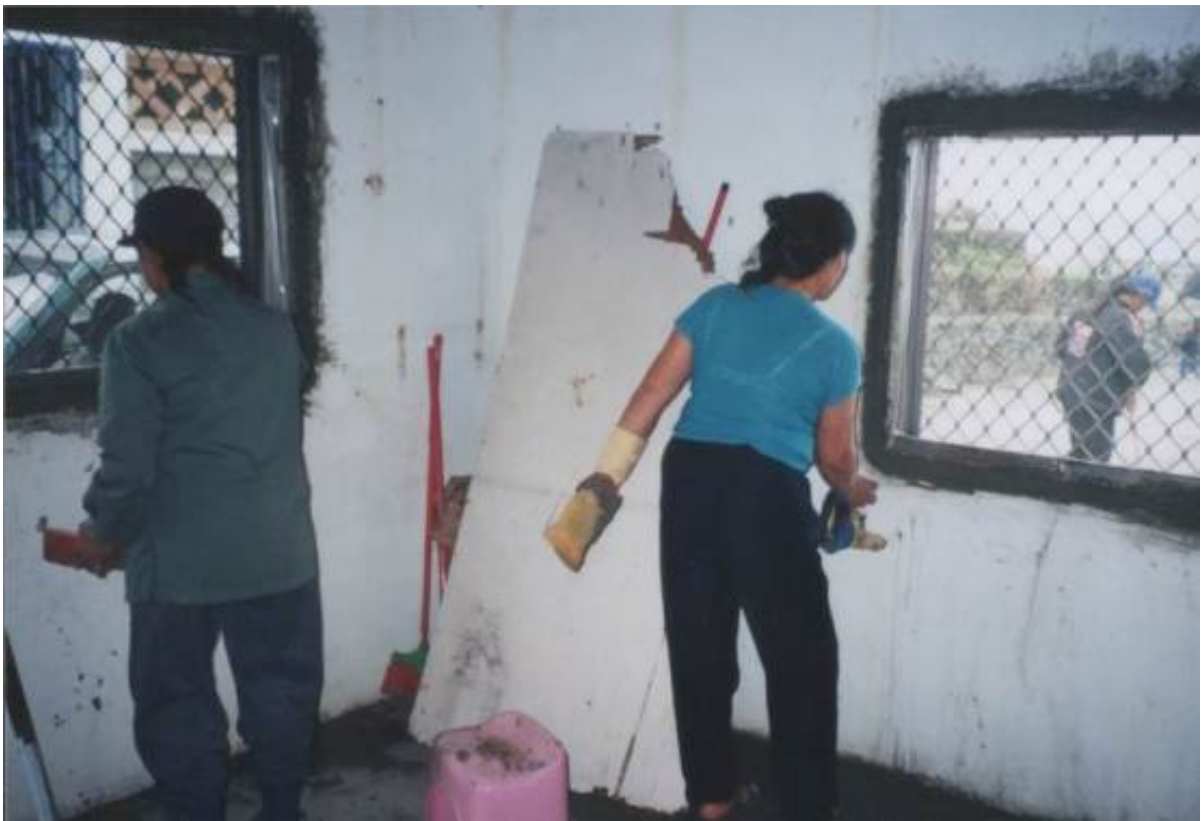
2004年1月 和朗島的義工媽媽們一起為新裝上的窗框敷上水泥，大家都有自己蓋房子的經驗，個個皆是勞動能手。
