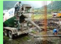
攪拌車在地基工地現場
